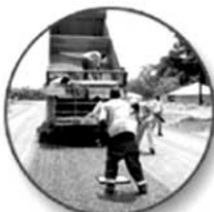
Aménagement de chaussées
